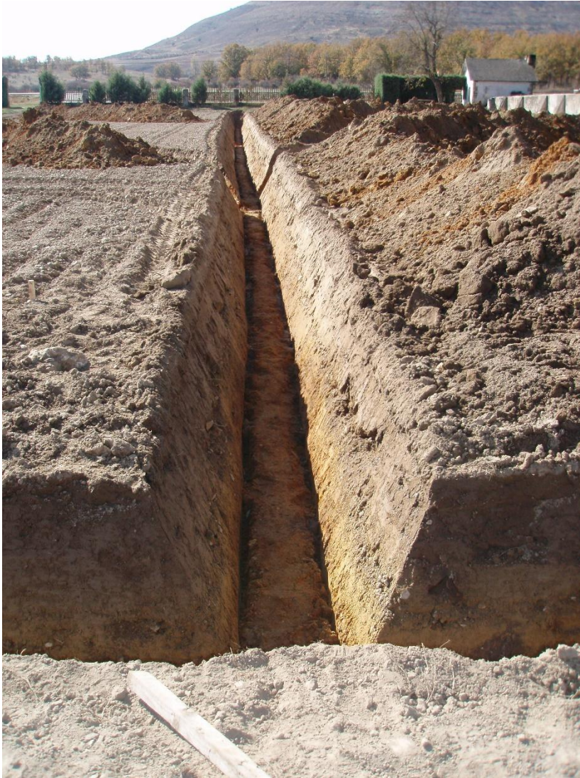
Fig. instalación drenaje subterráneo parcela 1
